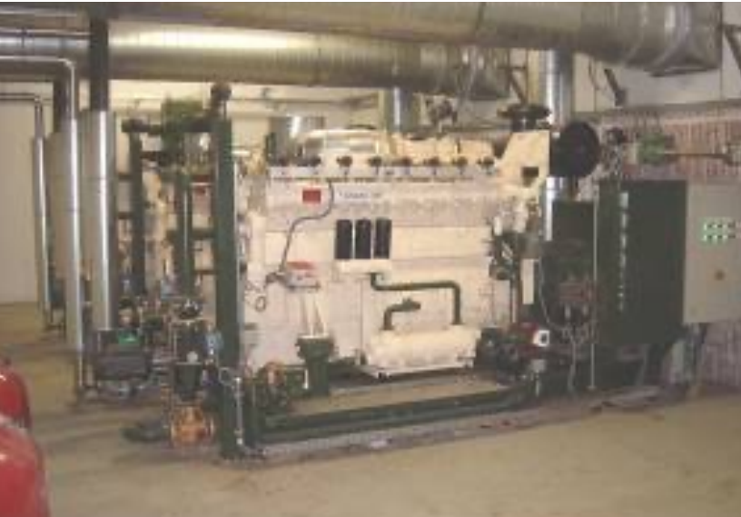
GRUPO ELECTRÓGENO EN CASA DE MÁQUINAS
