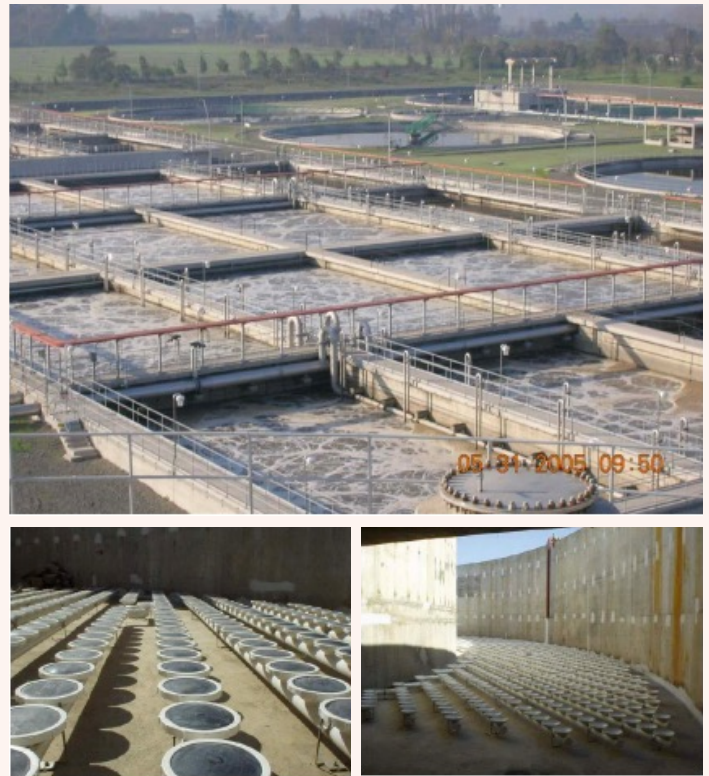
○ Figura 3. Fotografías de un sistema de lodos activados con sus respectivos difusores de aire.
