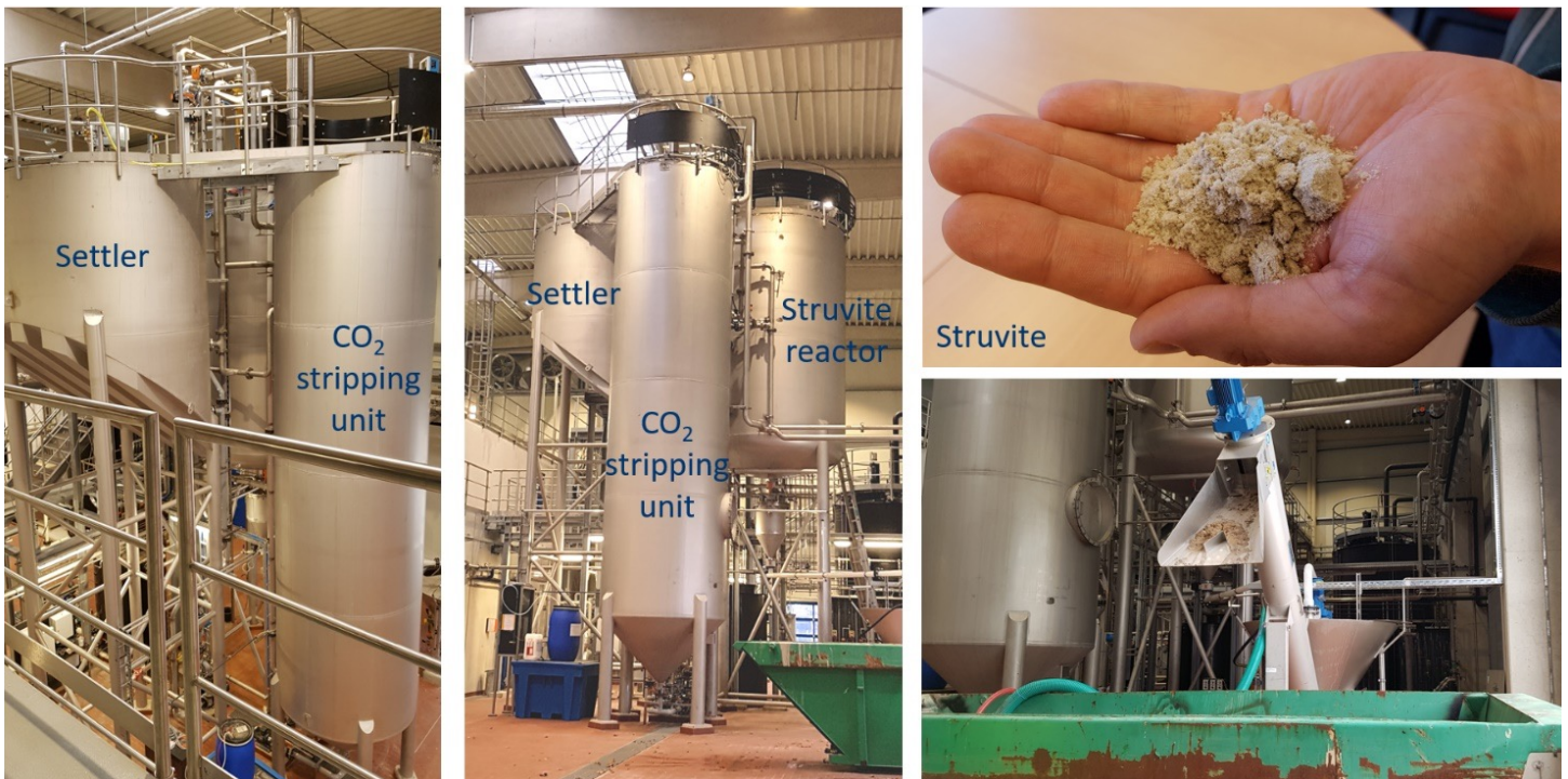
Figura 27: Producción de estruvita incorporando unidad de stripping de CO2
